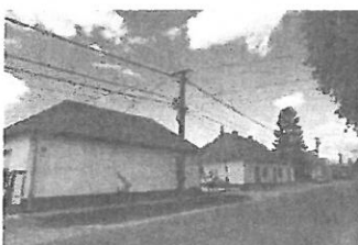
Utcával párhuzamos épületek a Községháza mellett
